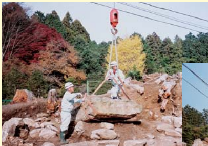
天井石の移動
